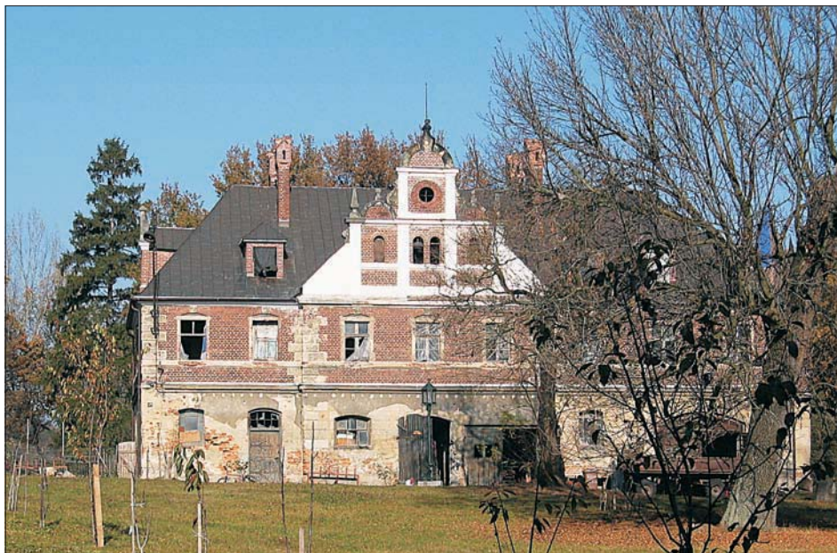
58. Oficyna – wozownia (w trakcie remontu)
